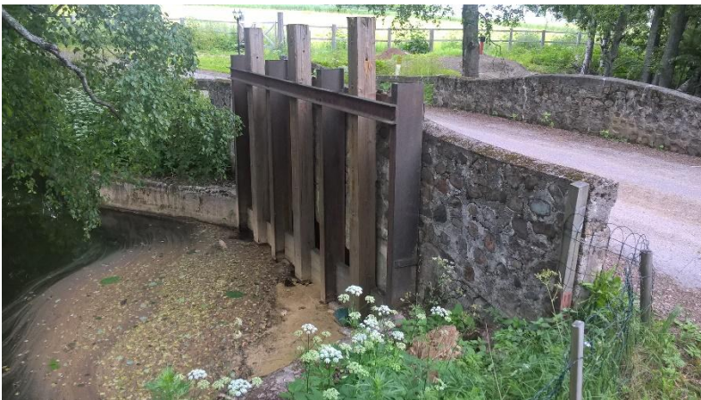
Kuva 1.5. Juoksutuspato kuvattuna ylävirran puolelta.
