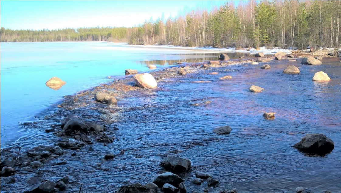
Kuva 3.1. Hankajärven Reinikoskelle toteutettu pohjapato.
